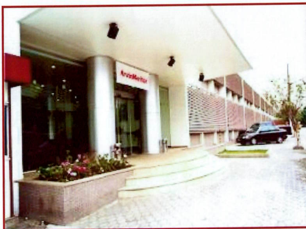
Fig. 4.2 – Vista da Fachada da Recepção
