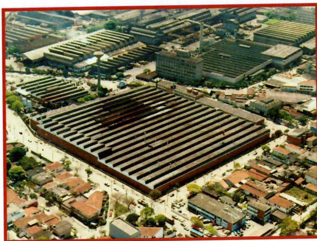
Fig. 4.1 – Vista Aérea da Fábrica
